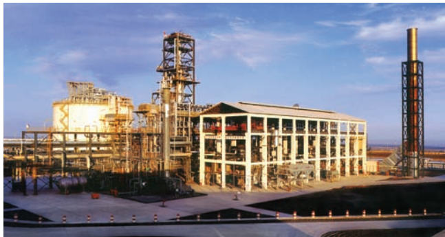
Linde LNG plant supplied to China
