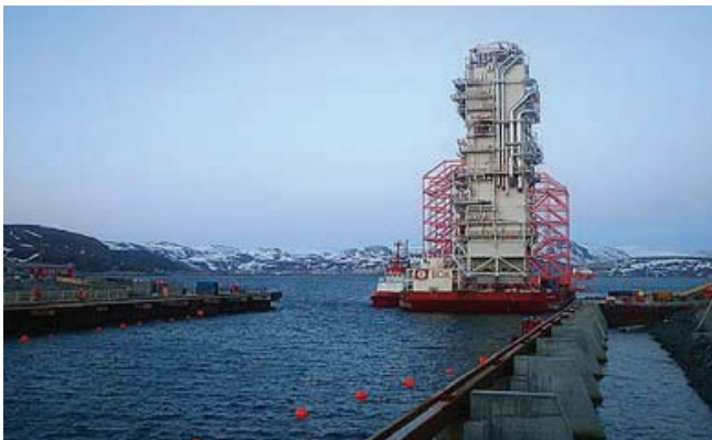
LNG cold box enroute to Hammerfest, Norway
